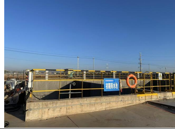
初期雨水收集池
