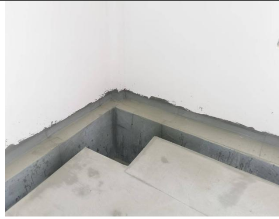
渗滤液收集池
