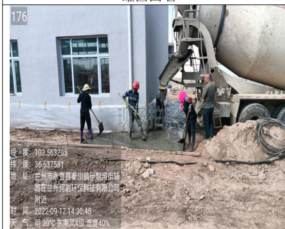
危废贮存库防渗施工
