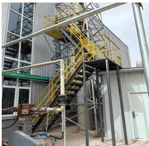
排气筒及采样平台
